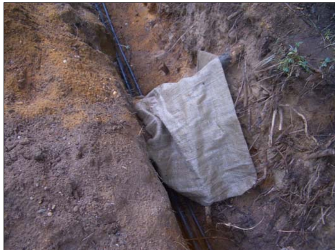
Abdeckung der freigelegten Wurzeln mit einem Leinensack
