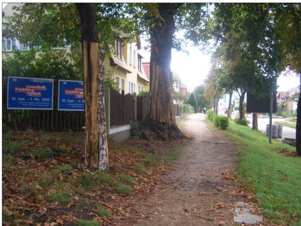
Gehölzschutz mit Bretterummantelung
