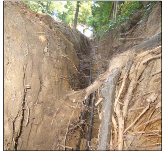
Kabelverlegung im Wurzelbereich einer Eiche
