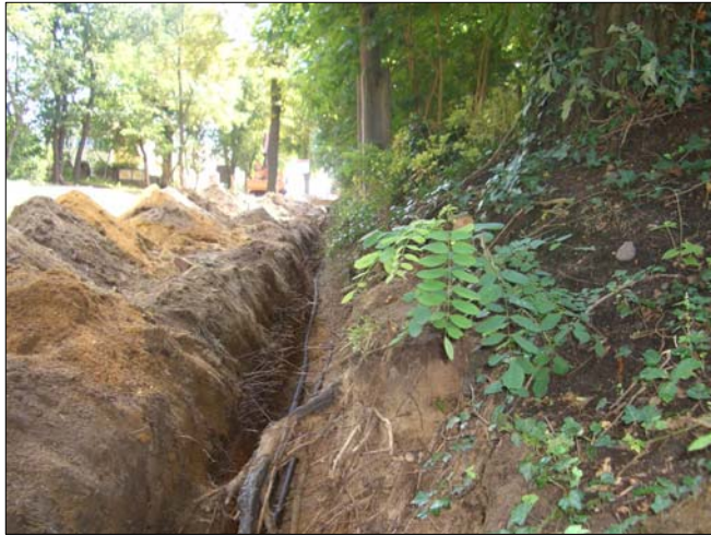
Kabelverlegung im Wurzelbereich einer Eiche
