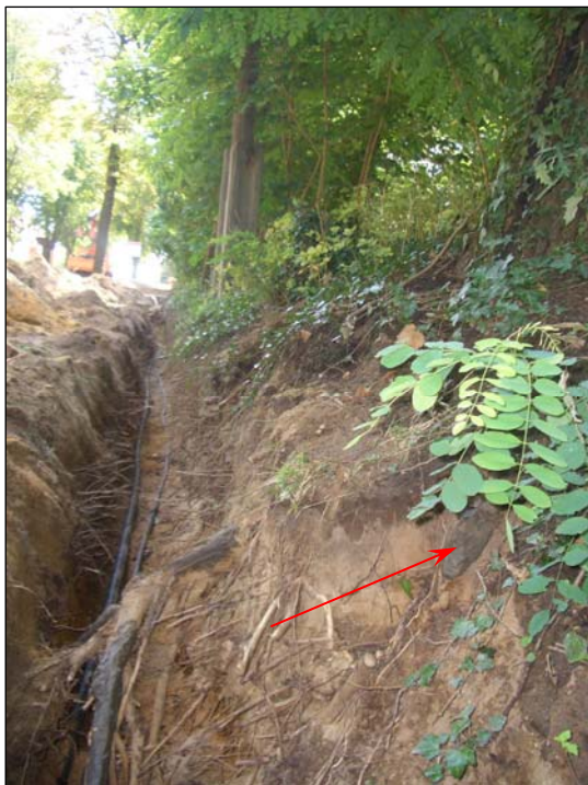
Kabelverlegung im Wurzelbereich einer Eiche
