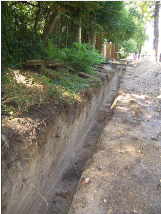
Kabelschachtabschnitte ohne bedeutsame Baumwurzeln
