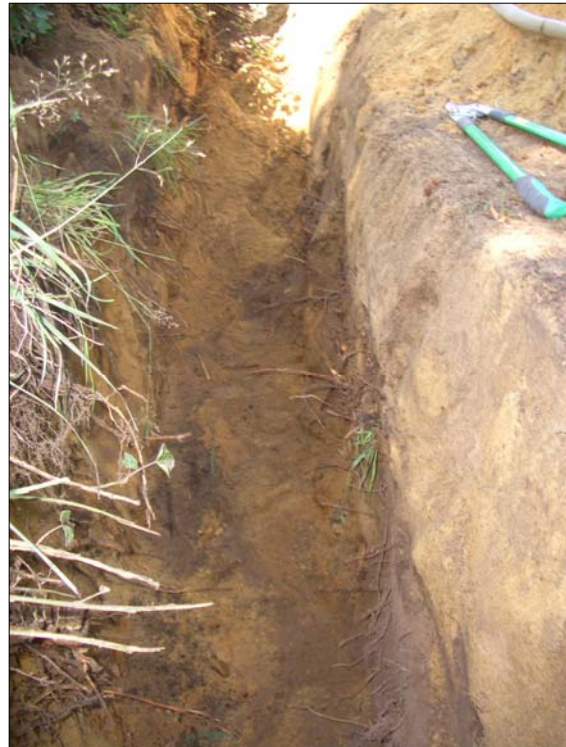
Kabelschachtabschnitte ohne bedeutsame Baumwurzeln
